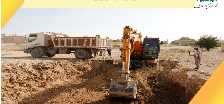
عملیات خاکبرداری کانال سیل بر (خیابان‌های لادن و شقایق) جهت هدایت آب‌های سطحی
