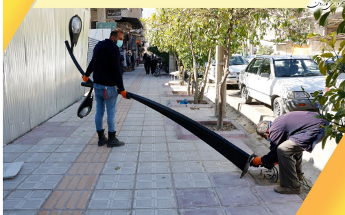
نصب پایه چراغ در راستای تأمین روشنایی خیابان شهدای شمالی
